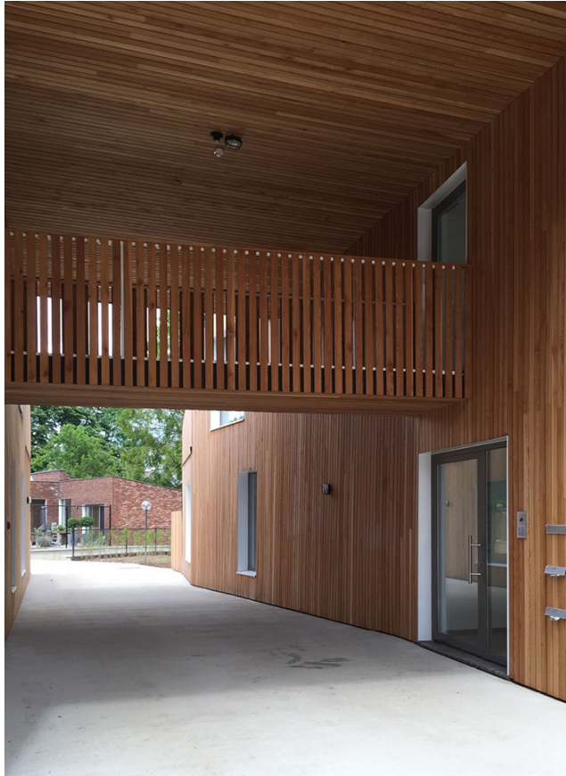
1 beeld doorheen de onderdoorgang in het appartementsgebouw
