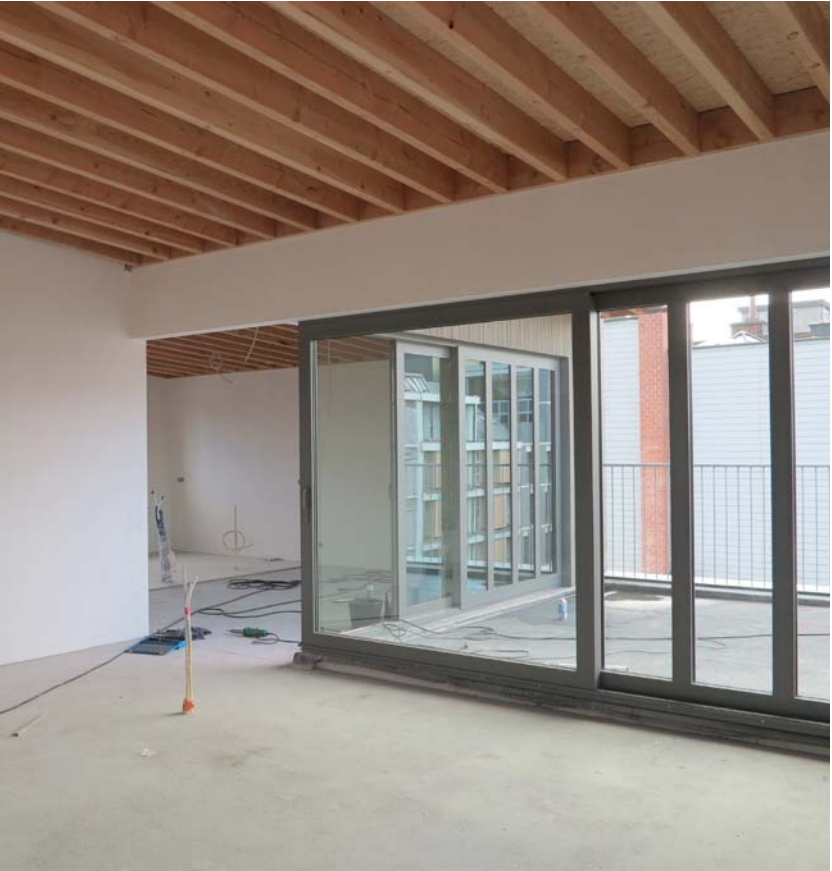
1 plan bovenste appartement 2 bovenste appartement in werffase
